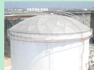
外浮頂槽增設頂蓋(內浮頂槽)
