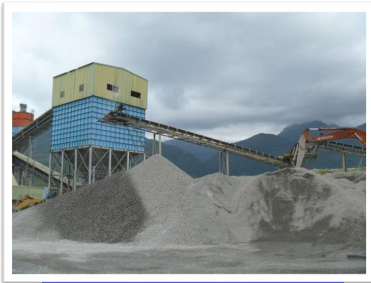
灑水範圍未涵蓋堆置區域
