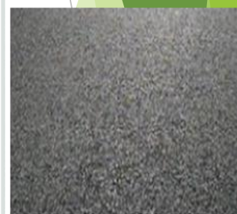
鋪設 瀝青混凝土
