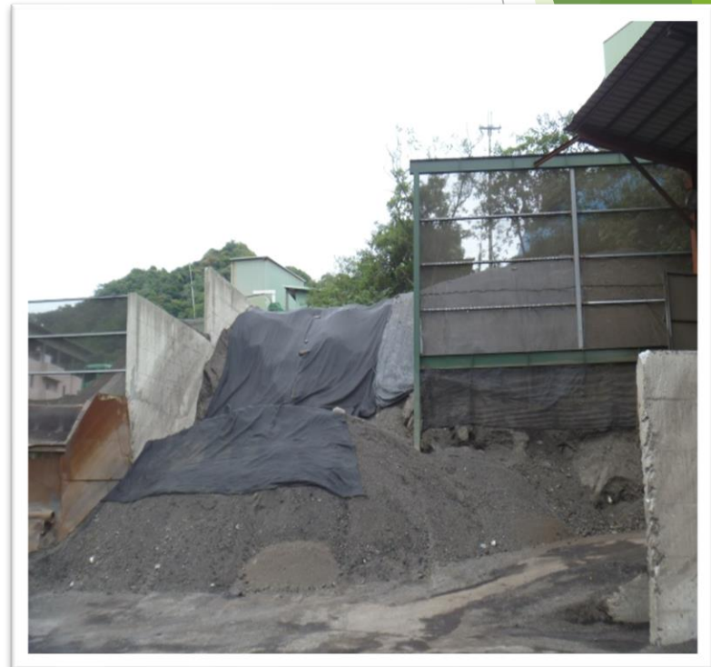
阻隔牆未完全圍封堆置區
