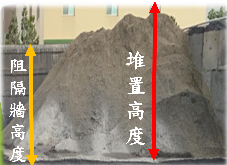
阻隔牆高度未達設計或實際堆置高度1.25倍
